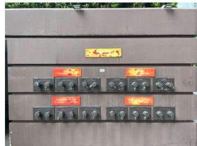
รูปที่ 2-41 หัวรับน้ำดับเพลิงภายนอก อาคาร
