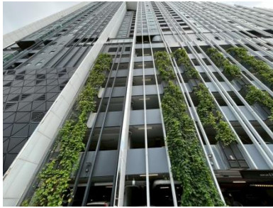
รูปที่ 2-4 ที่จอดรถอยู่ที่ชั้นที่ 1-6 โดยบริเวณชั้นดังกล่าวมีลักษณะเปิดโล่ง ไม่ปิดทึบ มีลมพัดผ่านตลอดเวลา อากาศหมุนเวียนได้สะดวก
