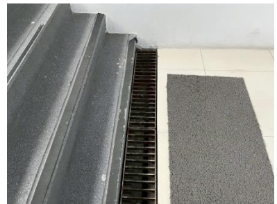
รูปที่ 2-67 ตะแกรงครอบตามรูท่อระบายน้ำ
