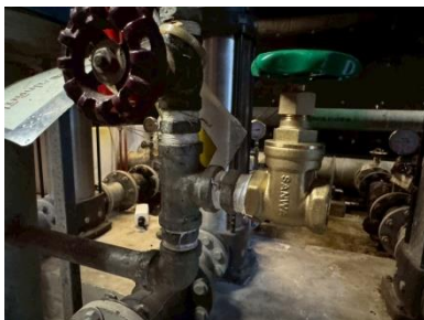
รูปที่ 2-8 บำบัดก๊าซมีเทนโดยรวมผ่านท่อขนาด 3 นิ้ว ต่ลงดิน
