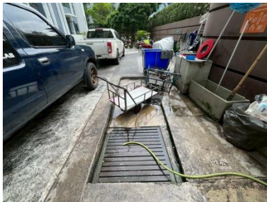
รูปที่ 2-33 ท่อรวบรวมน้ำเสียที่เกิดจาก การล้างห้องพักขยะมูลฝอย
