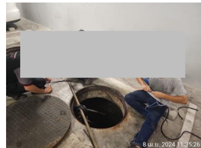
รูปที่ 2-76 ตรวจสอบการสะสมของตะกอนในบ่อพักน้ำภายในโครงการ และท่อระบายน้ำภายในโครงการ
