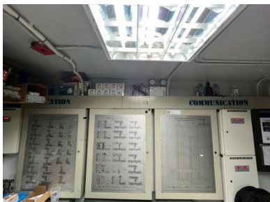
รูปที่ 2-45 แผงควบคุม (Fire Alarm Control Panel : FCP)
