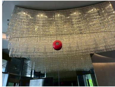
รูปที่ 2-49 สัญญาณกระดิ่งแจ้งเหตุ อัคคีภัย (Alarm Bell)
