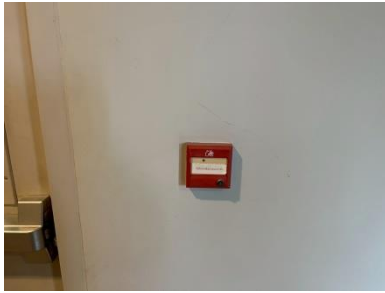
รูปที่ 2-48 เครื่องแจ้งเหตุโดยใช่มือดึง (Fire Alarm Manual Station)
